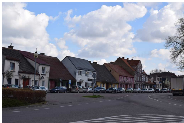
Fot. 1. Zwarta zabudowa mieszkaniowa w centrum Szamocina
