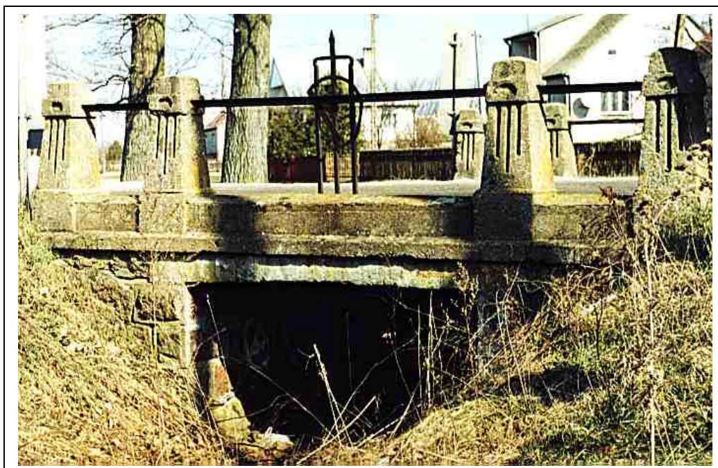
Fot.10 Przepust drogowy mur.-kam. z początku XX w. (wpisany do rejestru zabytków – nr rej.542) -droga powiatowa odcinek Orla – Reduty 2002r.
